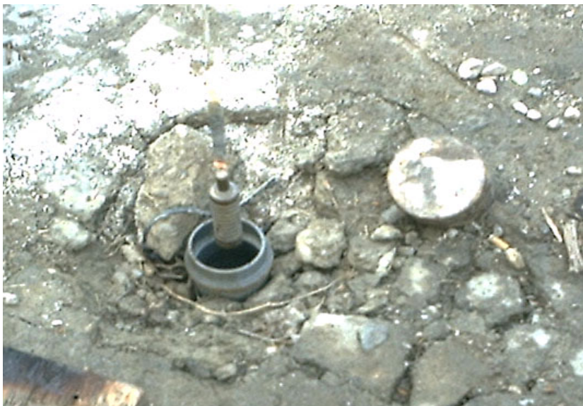
Фото 1 - Пијезометар КМ-2 /По/ у нивоу терена изграђен од ПВЦ цеви
