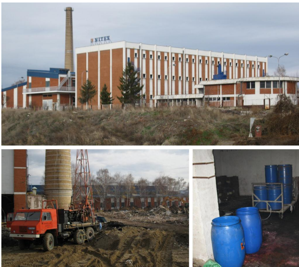
Slika 4.49. Istražni radovi na lokaciji fabrike "Nitex" u Nišu
