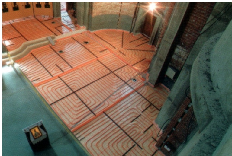
Slika 184. Podni paneli u fazi montaže ( www.sm-inzenjering.rs )
