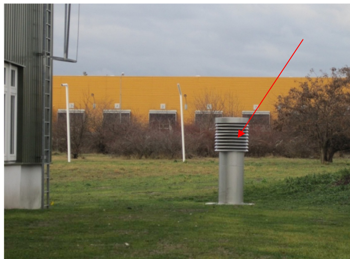
Slika 214. Antimikrobski izmenjivač toplote zemlja-vazduh "AWADUKT Thermo" (foto: A. Vranješ)
