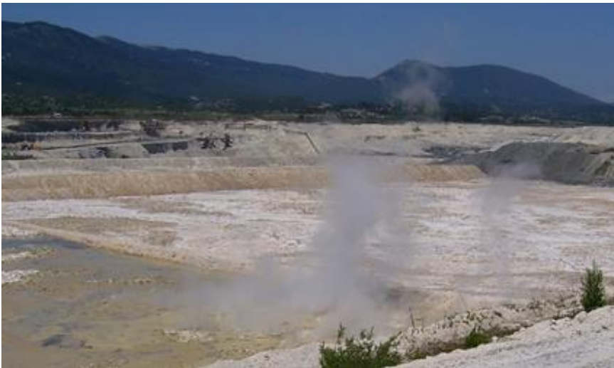
Слика 6.4. Егзотермна реакција \text{CaO} на депонији пепела ТЕ "Гацко"
