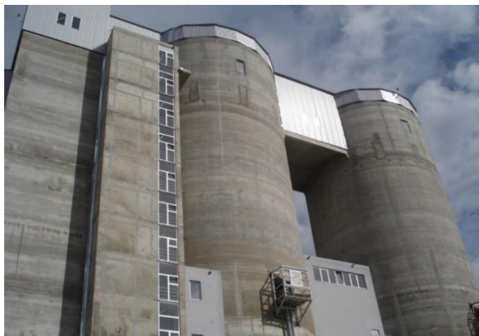
Слика 10.12. Силоси за привремено складиштење пепела и шљаке на ТЕ "Никола Тесла Б"
