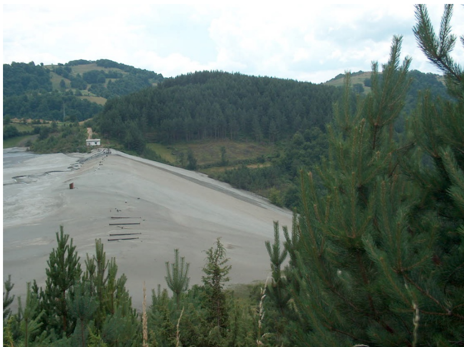
Сл. 33. Велика брана (и круна бране) флотацијског јаловишта рудника Грот
