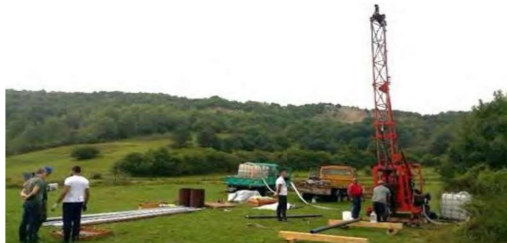
Слика 2. Бушење истражних бушотина на пројектованим локацијама Церничког поља (Сорајић & Милановић (2018) )
