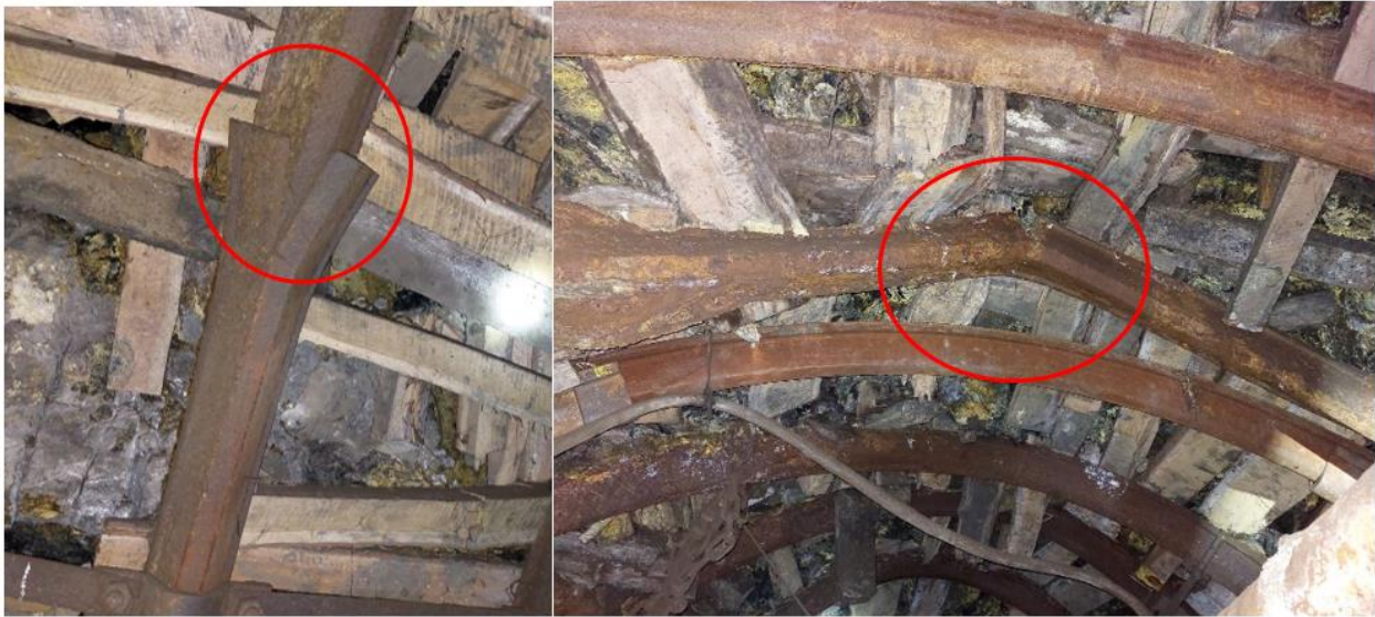
Слика 6.3 – Пример деформације челично лучне конструкције у Ибарским рудницима каменог угља
