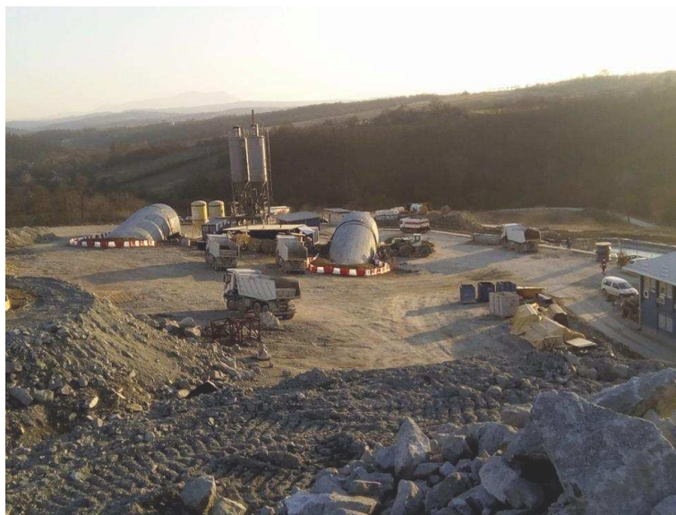
Slika 28. Izgled ulaznog portala u niskop sa odlagališta
