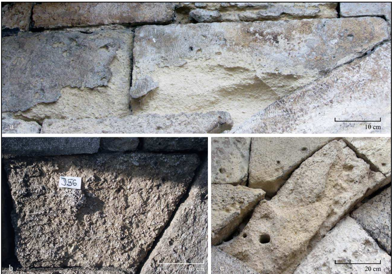
Sl. 54. Dubinsko raspadanje krečnjaka Mračne kapije: a) blokovi grainstone iznad unutrašnjeg luka II fasade zahvaćeni intenzivnim dubinskim raspadanjem i sa ostacima površinske kore/ljuske; b) algalni rudstone u gornjoj zoni zapadnog dela II fasade; c) dubinsko raspadanje peskovitog rudstone u unutrašnjem luku zapadne strane II fasade sa ovalnim šupljinama antropogenog porekla
