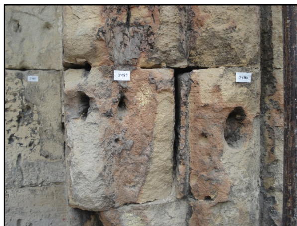
Sl. 119. Dekoloracija grainstone usled izloženosti visokoj temperaturi
