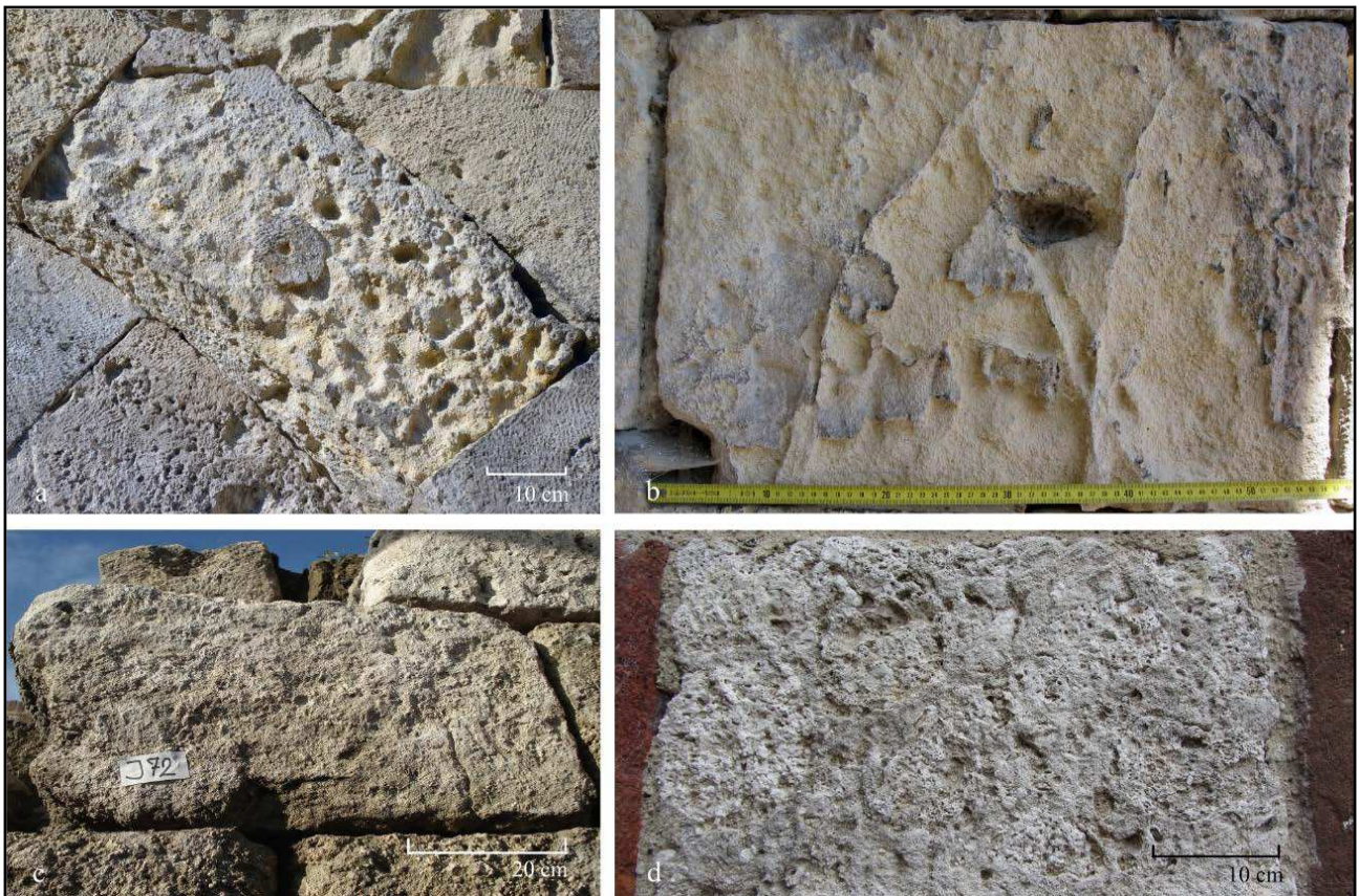
Sl. 55. Reljefno raspadanje krečnjaka Mračne kapije: a) alveolizacija bloka grainstone u unutrašnjem luku JI fasade; b) diferencijalno raspadanje kod grainstone sa istaknutim otpornijim žicama i ostacima crne kore u zoni profilisanog portala istočnog dela JI fasade; c) zaobljavanje ivica i uglova algalnog rudstone u završnom vencu zapadnog dela JI fasade; d) ispiranje komponenti algalnog rudstone na istočnom delu SZ fasade
