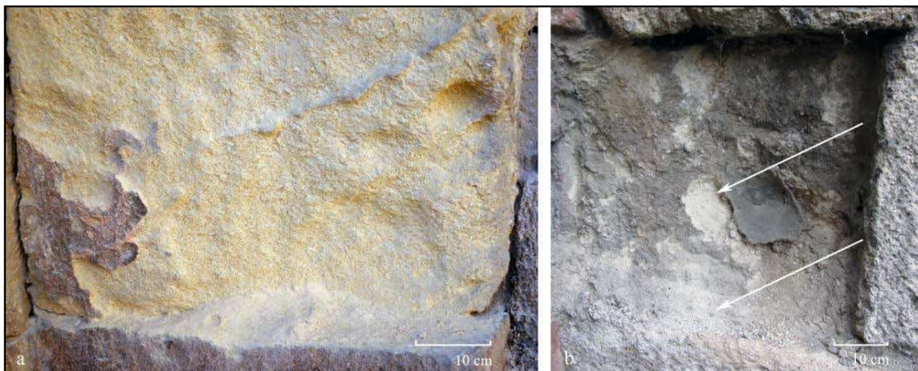
Sl. 61. Zrnasta dezintegracija blokova krečnjaka Mračne kapije: a) intenzivna zrnasta dezintegracija bloka grainstone u profilisanom luku istočnog dela II fasade; na bloku je prisutno i diferencijalno raspadanje i ostatak površinske kore; b) intenzivna zrnasta dezintegracija algalnog rudstone nakon odvajanja crne kore (gornja strelica) uz segregaciju dezintegrisanog materijala (donja strelica) - istočni deo SZ fasade
