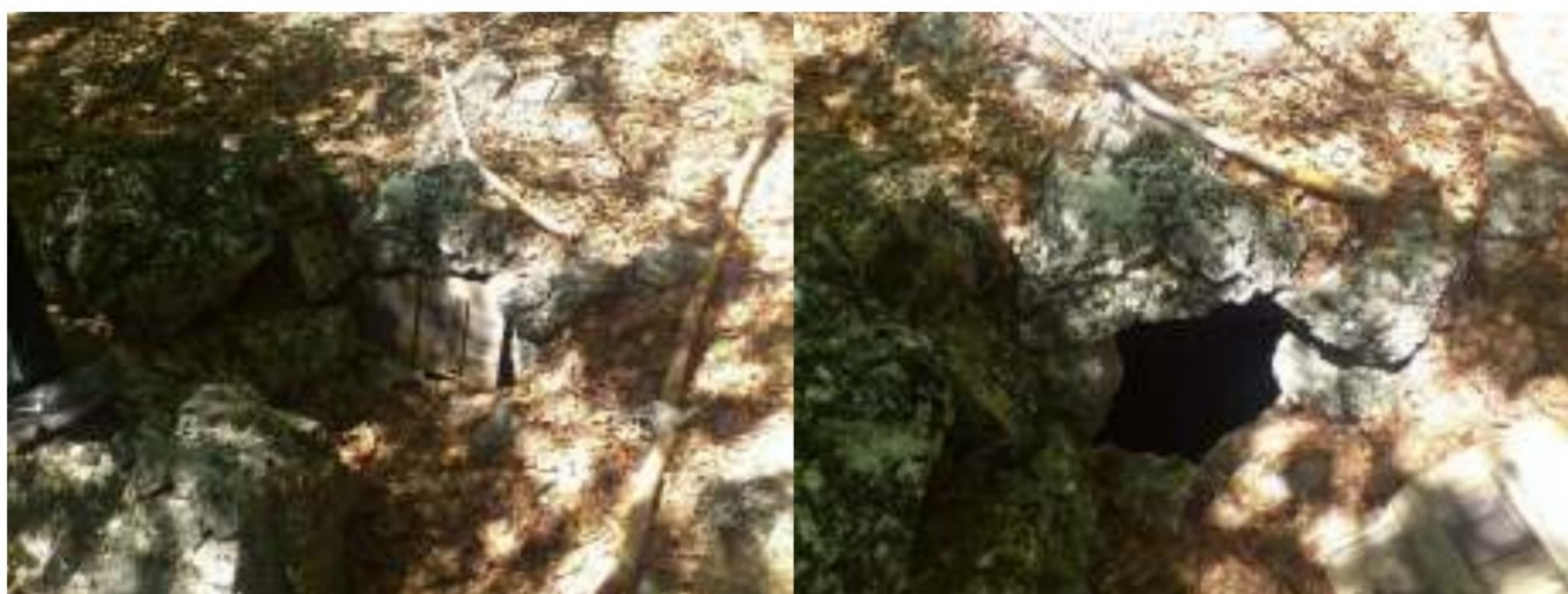
Slika 6.29. Primitivna kaptaža izvora na desnoj obali jaruge Prosek
