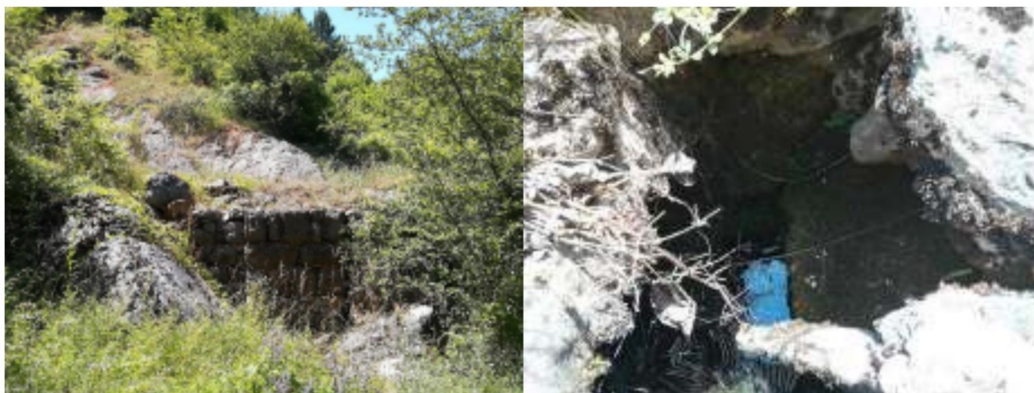
Slika 6.23. Kaptaža vrela u Bežištu
