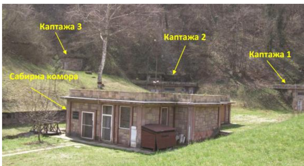
Слика 6.3: Спољашњи изглед сабирне коморе и положај у простору у односу на каптаже (фото: А. Дрчелић)
