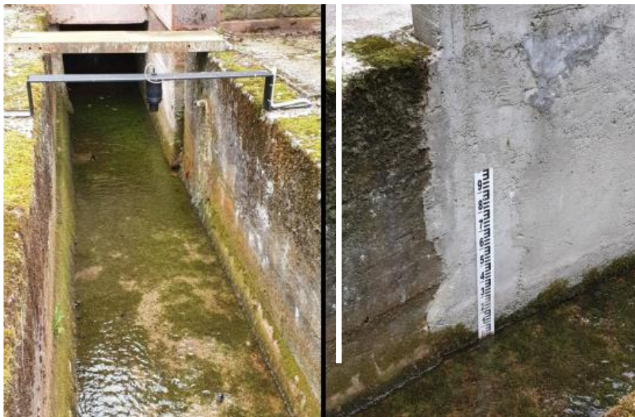
Слика 6.7: Преливни канал из сабирне коморе – бетонски канал који води до реке Студена (фото: А. Дрчелић)
