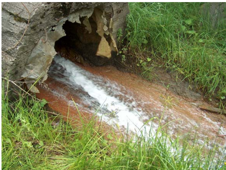
Сл. 24. Место „извођење“ воде са флотацијског јаловишта рудника Грот (испуст централног колектора)
