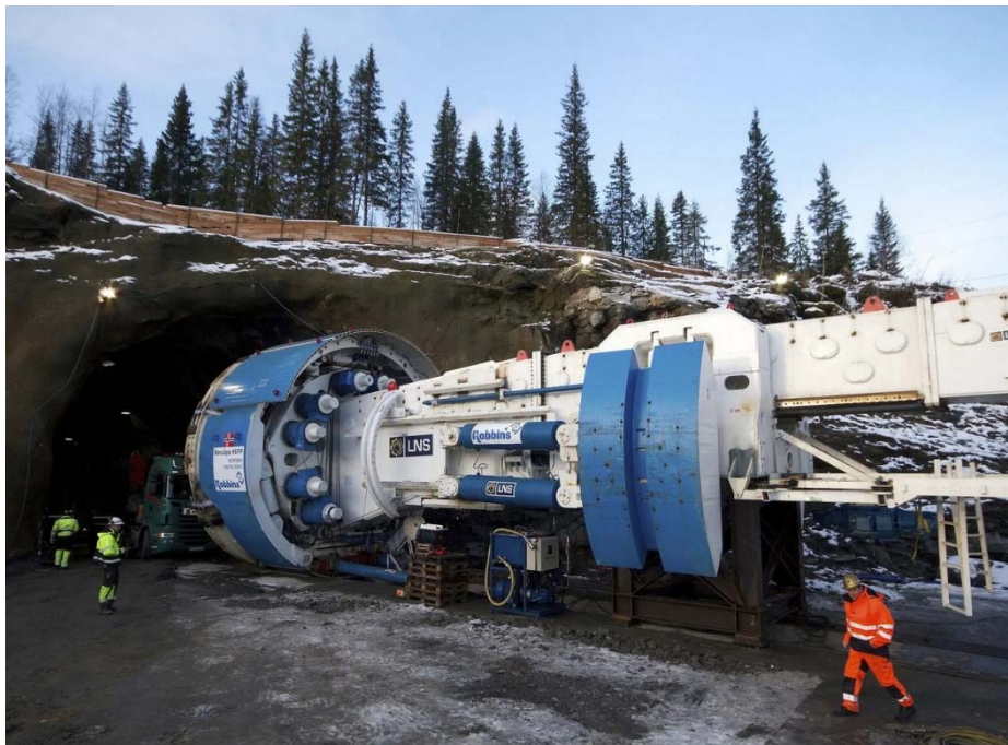
Slika 21. Pristup TBM mašine u tunel (izvor: sajt www.robbinstbm.com )
