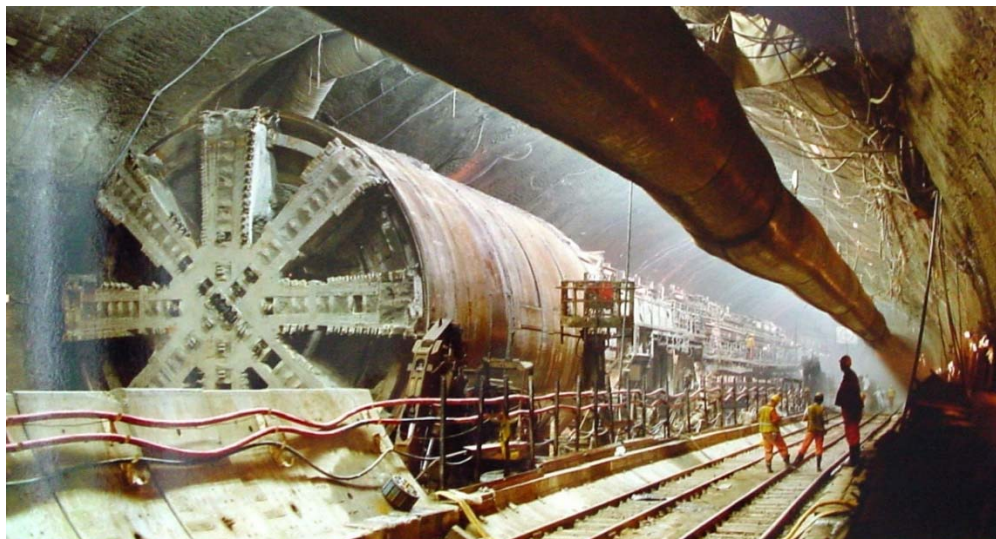
Slika 20a. Izgled TBM mašine prilikom izrade kanalskog tunela
