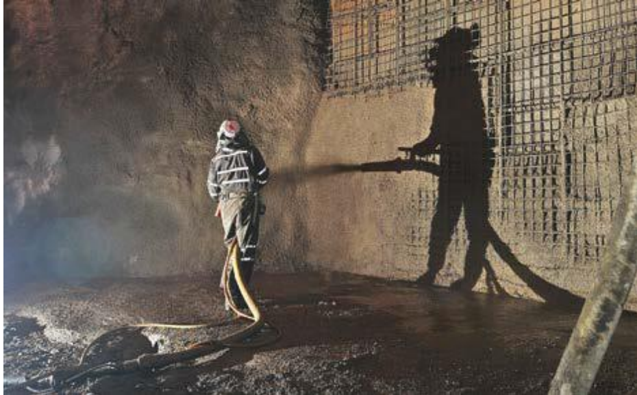
Слика 17. - Израда барикаде са мрежом и прсканим бетоном
