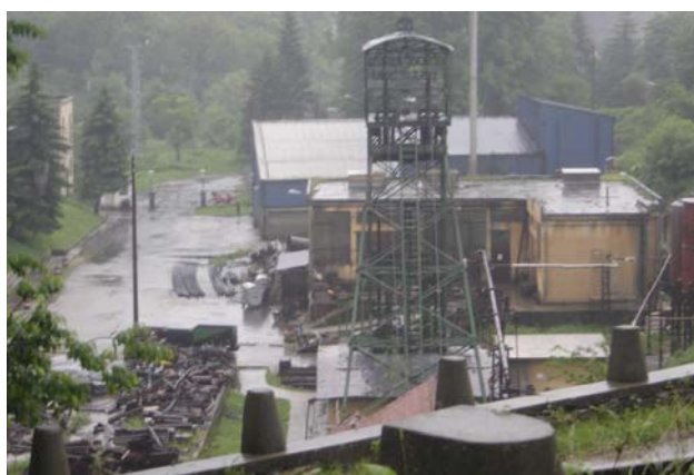
Slika 147. Servisno okno u Senjskom Rudniku (foto B.Miladinović)
