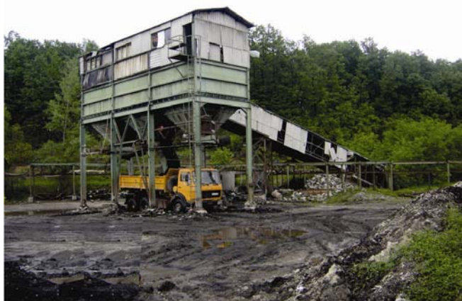
Slika 257. Prihvatni bunker uglja na izlazu iz jame „Bogovina“- istočno polje (foto B.Miladinović)
