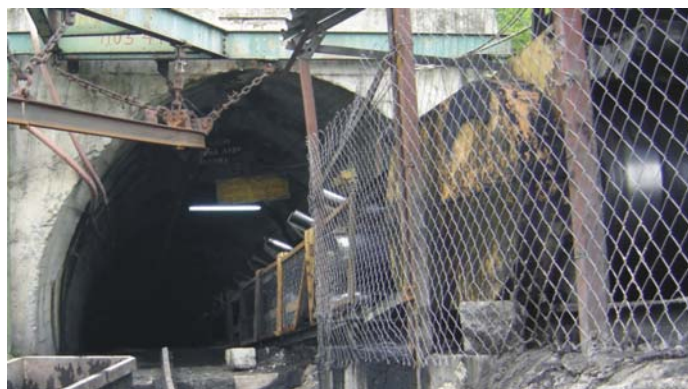
Slika 158. Ulaz u glavni izvozni niskop GIN-1 jame “Bogovina”-istočno polje (foto B.Miladinović)
