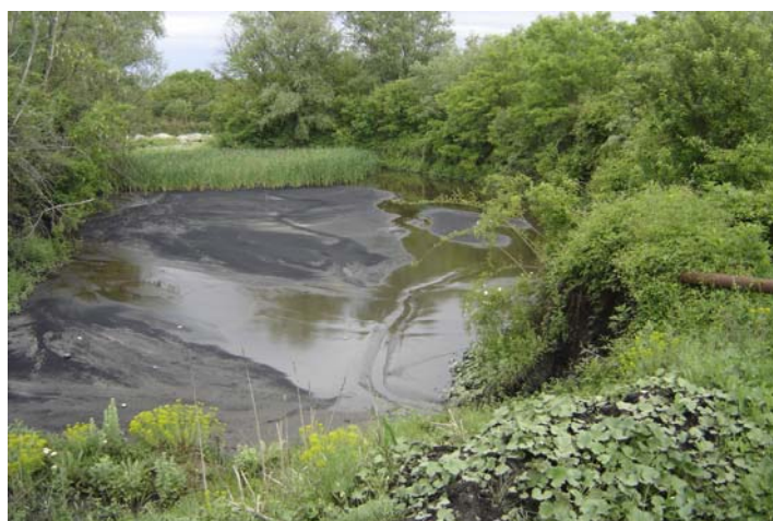
Slika 265. Bazen za taloženje mulja iz otpadnih voda separacije uglja u Bogovini (foto B.Miladinović)
