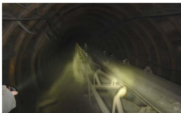
Slika 185. Glavni transportni niskop GTN u jami rudnika "Lubnica"
