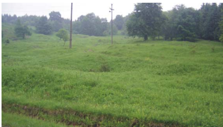
Slika 113. Deformacije površine terena uslovljene zarušavanjem krovine u jami „Senjski Rudnik“ (foto B.Miladinović)
