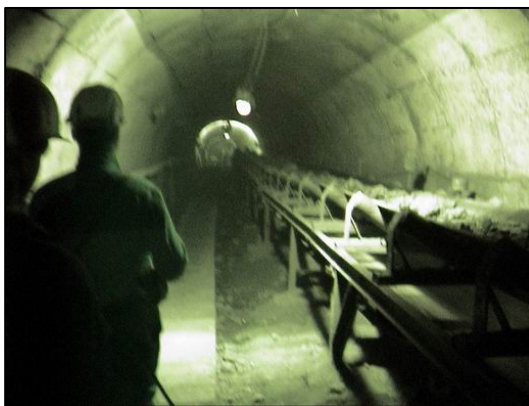
Slika 152. Glavni ventilaciono-transportni niskop GVN jame rudnika "Jasenovac" (foto M.Petrović)
