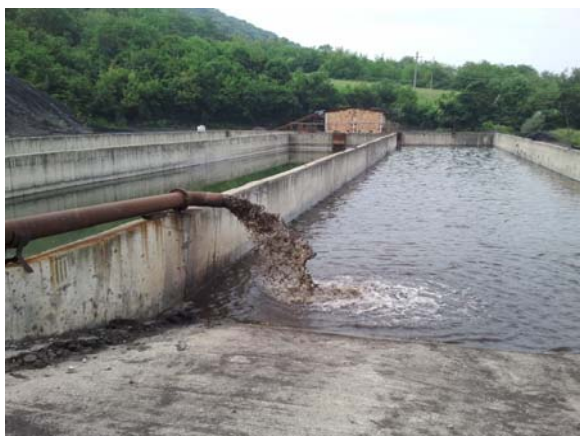
Slika 263. Betonski bazeni za taloženje otpadnog mulja sa separacije uglja rudnika „Vrška Čuka“ (foto B.Miladinović)
